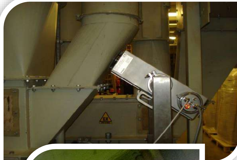
Instalação na saída do silo
